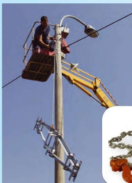
Aparat služi za zatezanje vazdušnih vodova i dizanje tereta. Jedan kraj uređaja se fiksira za stub, fasadu ili sličan nepokretan objekat. Pomeranjem ručice, aktivira se sistem zupčanika pri čemu se pokreće lanac. Montaža i primena uređaja je brza i laka. Maksimalna zatezna sila je 250 kg.
